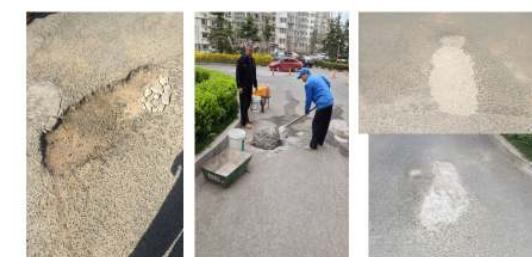
维修前 维修中 维修后
